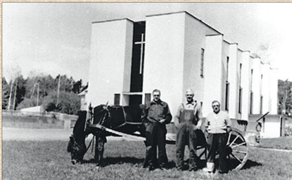
Hamar krematorium ca. 1950 .Ole Myrvang, to ukjente kirkegårdsarbeidere og hesten Pelle er i ferd med å opparbeide den nye urnelunden.
